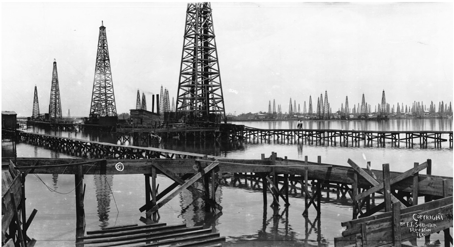
Torres de petróleo, Texas, USA
